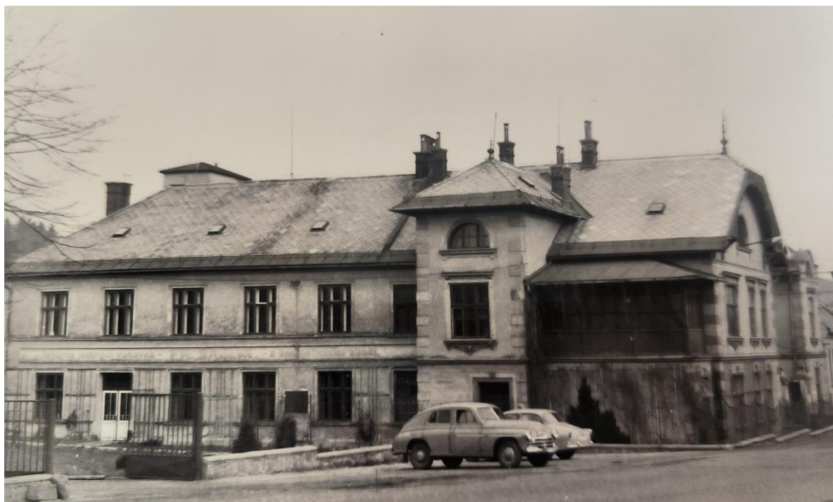
20. Původní budova firmy F. Sáblík (podnik Alpa Velké Meziříčí) v polovině 20. století.
