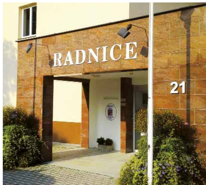
REKONSTRUKCE – Nově upraven byl vstup do budovy městského úřadu.
