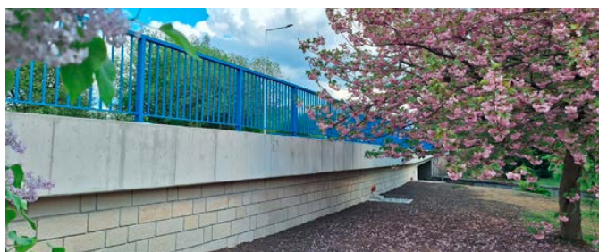
Most přes Kozský potok získal novou finální podobu. V rámci rekonstrukce, jejímž investorem byl Jihočeský kraj, byl nyní dokončen také nový obklad mostu. Ten stavbě velmi sluší, dodává jí elegantní vzhled a citlivě doplňuje okolní prostředí.
