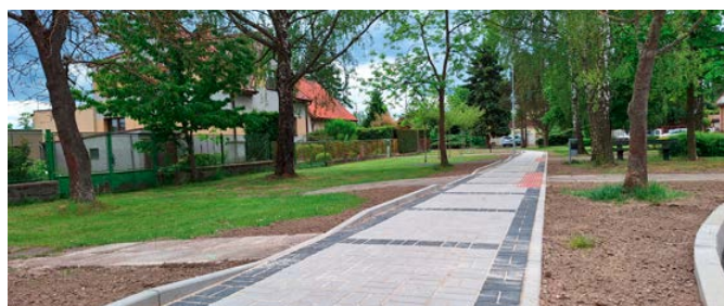
Ulice Boženy Němcové má novou a bezpečnější podobu. Dokončená rekonstrukce chodníku přinesla pohodlnější pohyb pro chodce a součástí prací bylo také doplnění veřejného osvětlení kolem parčíku. Celý prostor tak působí upraveněji, příjemněji a je bezpečnější i ve večerních hodinách.
