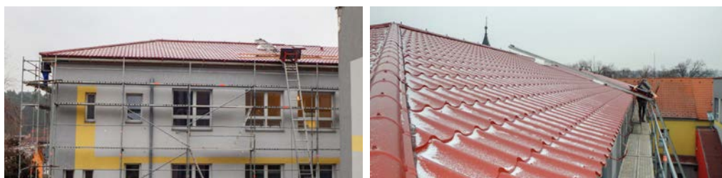
OPRAVA STŘECHY ZŠ ŠVEHLOVA - dokončuje se střešní krytina, následně proběhne bednění římsy a montáž okapů a hromosvodu. Foto: J. Novotný
