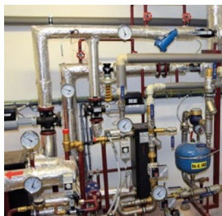
Předávací výměňková stanice je umístěna v suterénu administrativní budovy házené. Vytápění haly zajišťují nové radiátory a pomocné větrací a tepelné jednotky umístěné v hale.
