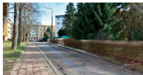
Rekonstrukce ul. Pionýrů
