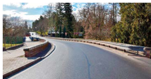
Rekonstrukce mostu přes Kozský potok
