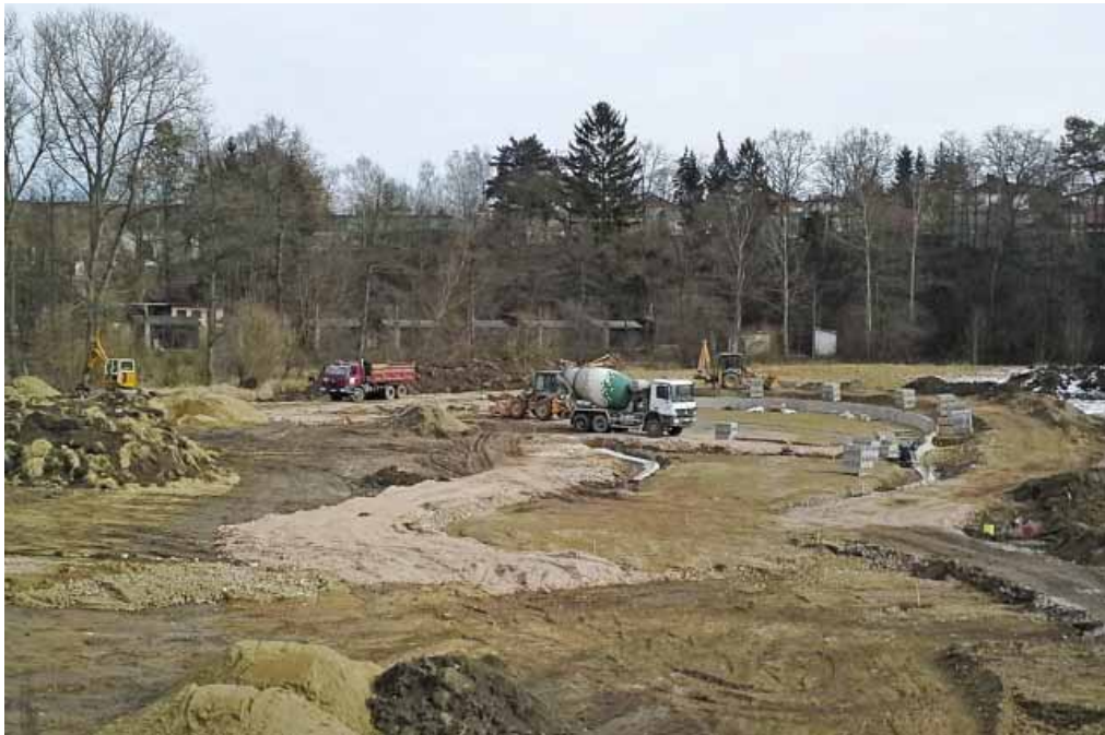
KOUPALIŠTĚ – předpokládaný termín dokončení stavby je 15. července 2014
